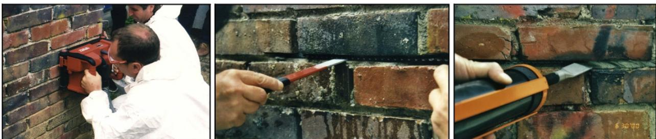
Abb. 2: Verarbeitungsschritte bei der horizontalen Verlegung von Spiralankern
