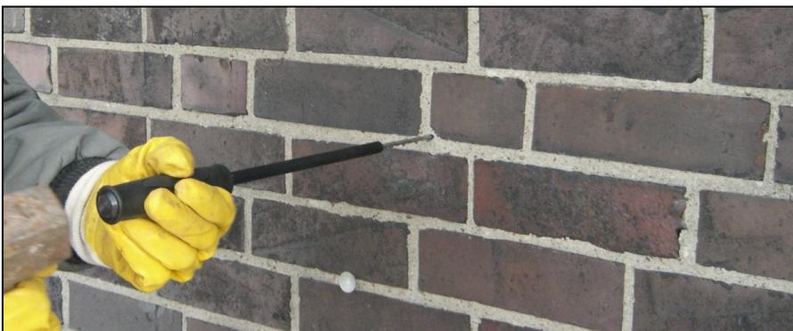
Abb. 2: Verankerung einer Klinkerfassade in Essen im Trocken-Verfahren
