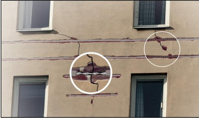
Risse im Mauerwerk entstehen oftmals infolge einmaliger oder abklingender Ereignisse (z.B. Lastumlagerungen, Erschütterungen, Schwindprozesse), die Bewegung der entstandenen Rissufer hält jedoch aufgrund wiederkehrender Prozesse (z.B. Temperaturverfor-
